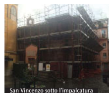
San Vincenzo sotto l'impalcatura
